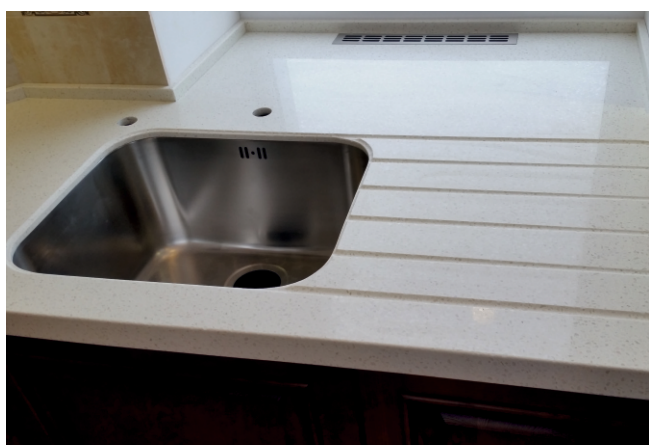
Фрезировка вокруг мойки/канелюры с наклоном
